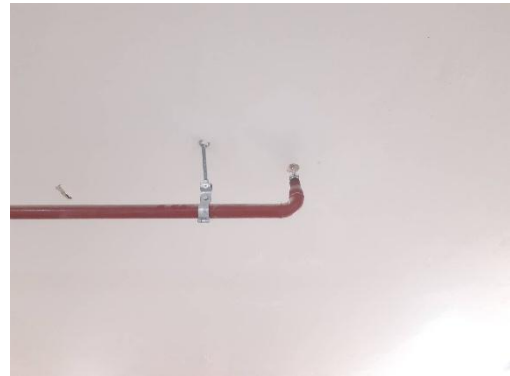
รูปที่ 33 ระบบหัวกระจายน้ำดับเพลิง
