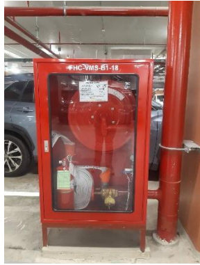
รูปที่ 34 ตู้เก็บสายฉีดน้ำดับเพลิง
